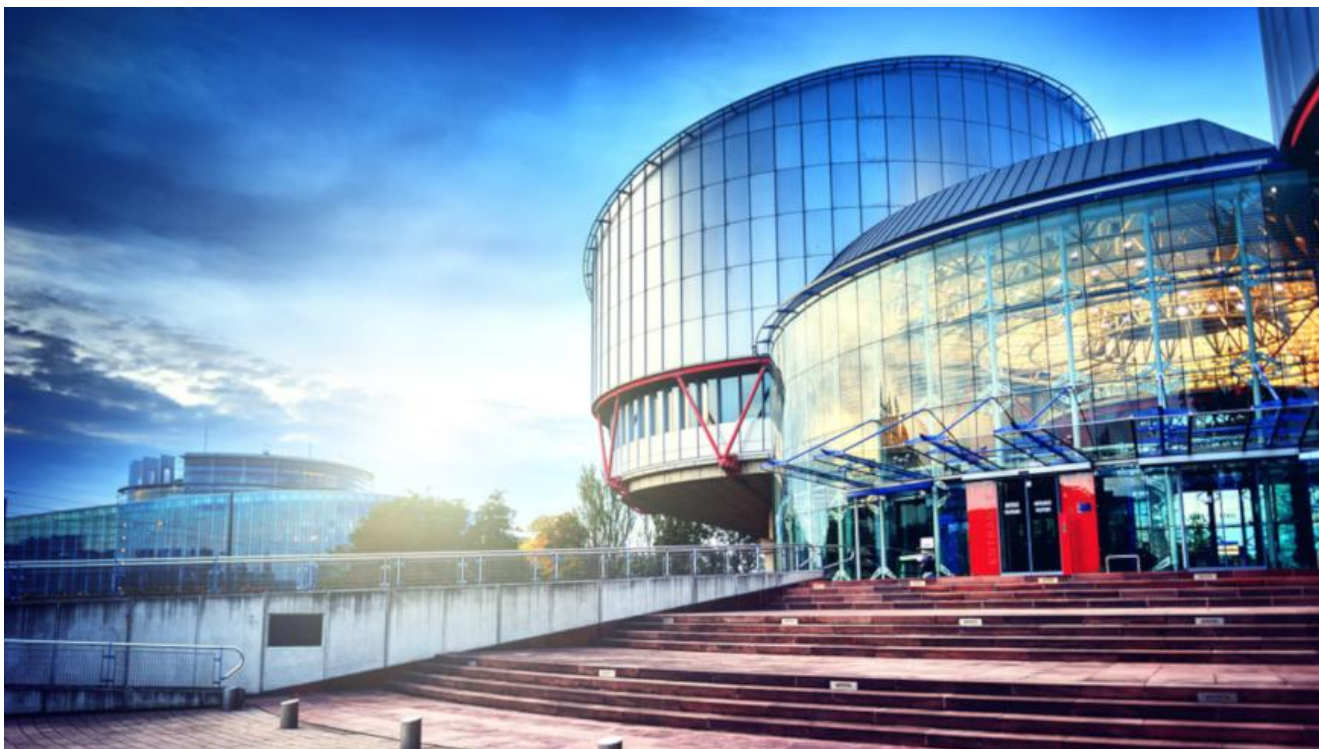
Будівля Європейського суду з прав людини, Страсбург, Франція. (прим. - ЮрФем) Фото: Shutterstock
